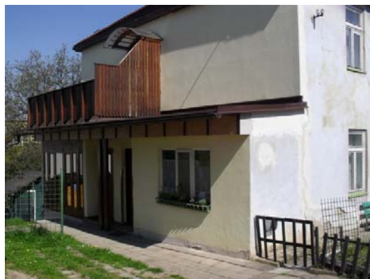
Obr. č. 75: Ul. Kotěrova. Ukázka rozdílného pojetí vstupu do domu. Skromnější vs. individualističtější. Jedná se omítnutý domek ze skupinky prvních postavených a dochovaných, tzv. „Pětidomí“.
