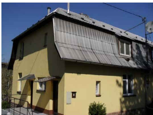
Obr. č. 20: Ul. Kotěrova, dům č.p. 858
