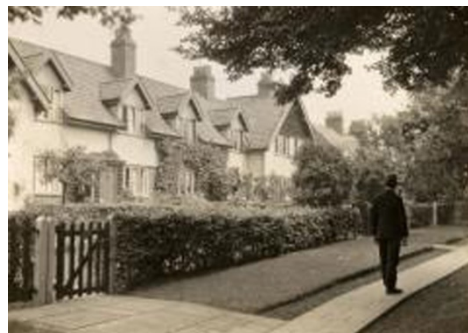
Obr. č. 6: Tři řadové domy na nádražní ulici v New Earswick. 1904
