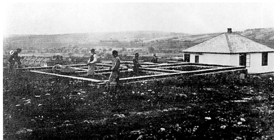
Obr. č. 14: Výstavba experimentálních dřevěných domků na Letné v roce 1919
