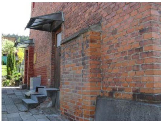
Obr. č. 74: Nový vstup do bytu byl při plošné rekonstrukci Letné vyrovnán s vchodem vedlejším. Umístěným výše. Vytratil se tím důvtipný důkaz o reakci architektury na stávající terén území
