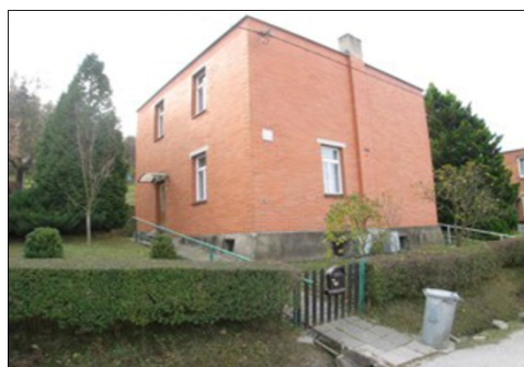
Obr. č. 26: Půldomek s nepůvodní stříšku nad vstupními dveřmi
