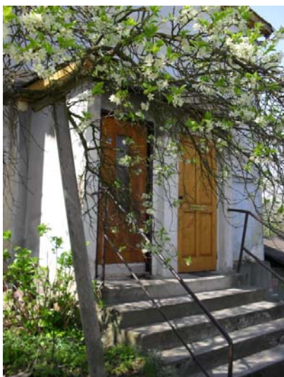
Obr. č. 84: Vyvýšený vstup do sousedních bytů v jednom z omítnutých domků tzv. „Pětidomí“
