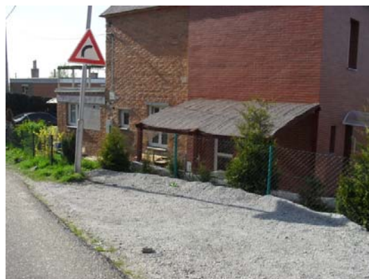
Obr. č. 65: Parkoviště s vyspanou celou plochou štěrkem
