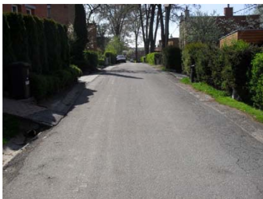
Obr. č. 76: Podoba stávajícího systému odvodnění zpevněných ploch
