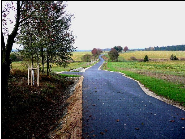
Příklad provedení cesty s vegetačně opevněným příkopem a mostkem pro vjezd na pole; zdroj: soutezsyr.spucr.cz
