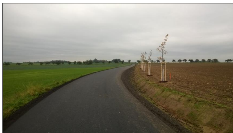
Příklad provedení cesty s vegetačně opevněným příkopem a pásovou výsadbou; zdroj: soutezsyr.spucr.cz
