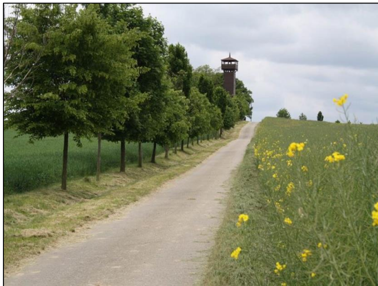
Příklad provedení cesty s mělkým příkopem a dřevinami ve finálním vzrostlém stavu; zdroj: soutezsyr.spucr.cz
