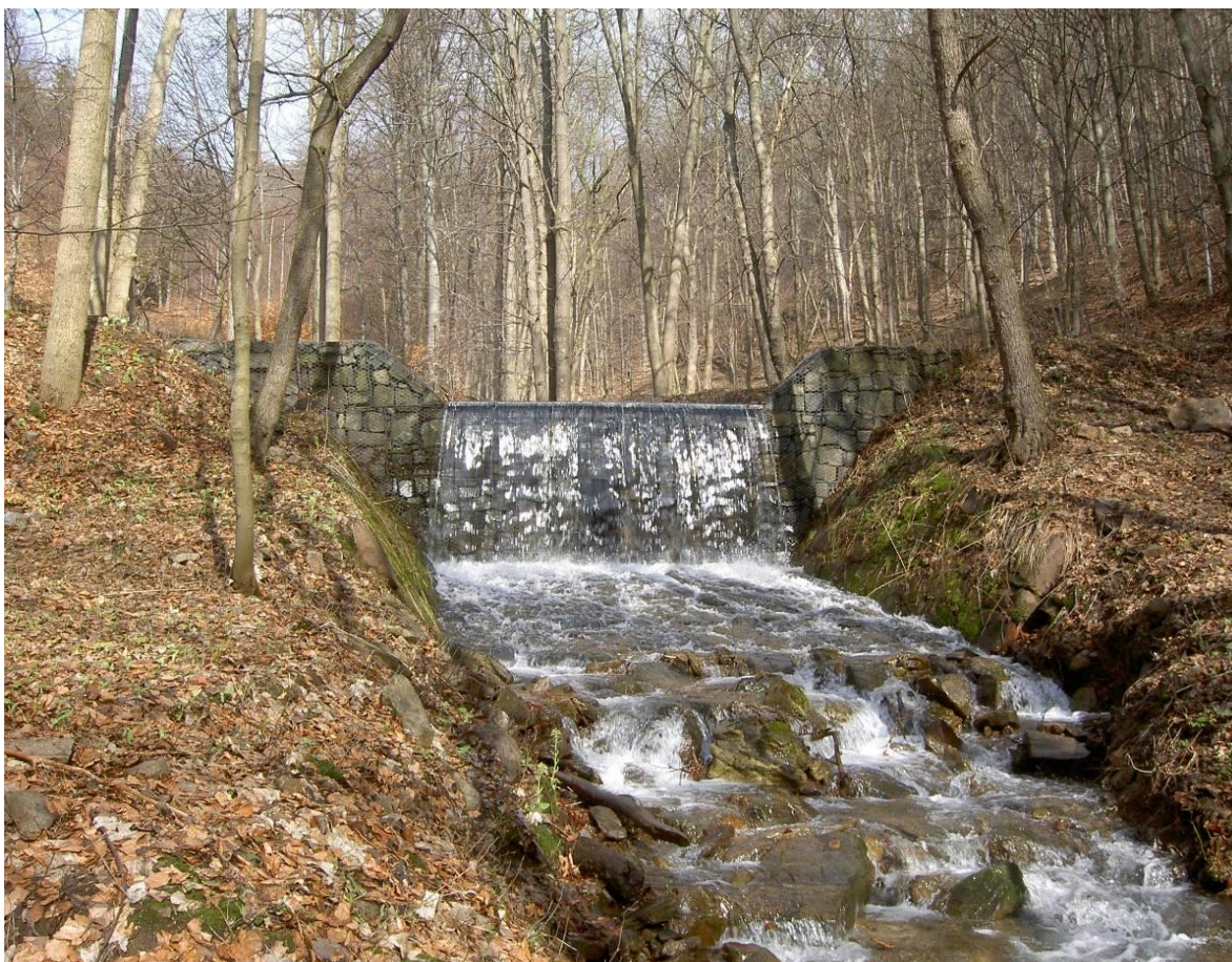
Obr. 8.10.5 Drátošterková přehrážka. Unčinský potok. Foto F.Křovák; 2010
