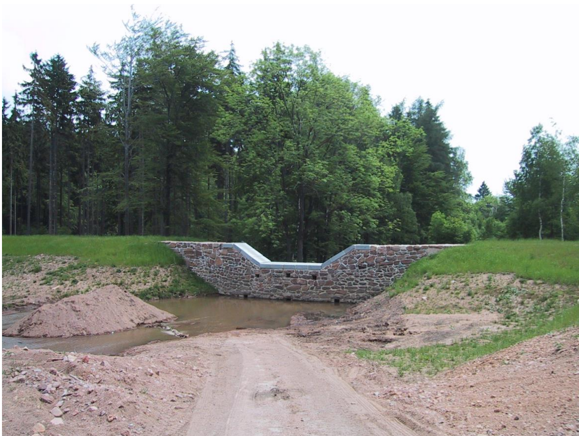
Obr. 8.10.7 Kamenná přehrážka s opevněným přepadem. Bystřice. Foto F.Křovák; 2010
