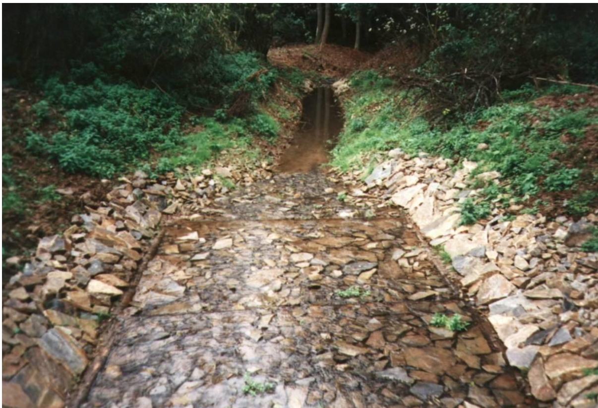
Obr.8.1.2 Kamenná rovnanina do dř. roštu. Oplanský potok. Foto F.Křovák; 2010
