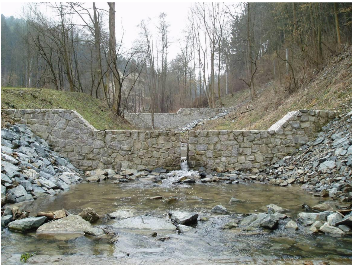
Obr. 8.10.3 Štěrbínová přehrážka na Dojetřickém potoce. Foto Bechyně 2007.
