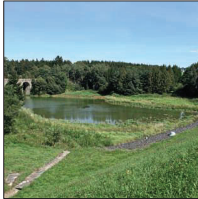
Foto č. 5: Viadukt přes vodní nádrž Němčice
