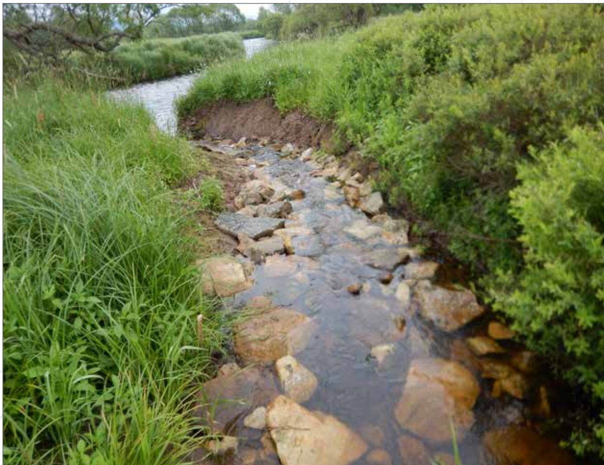
Obr. 136. Strmé ústí Žlebského potoka do Teplé Vltavy. Koryto zde bylo vymodelováno a zpevněno kameny, na rozdíl od ploché nivy, kde byl vodě ponechán prostor pro samovolné dotváření koryta.
