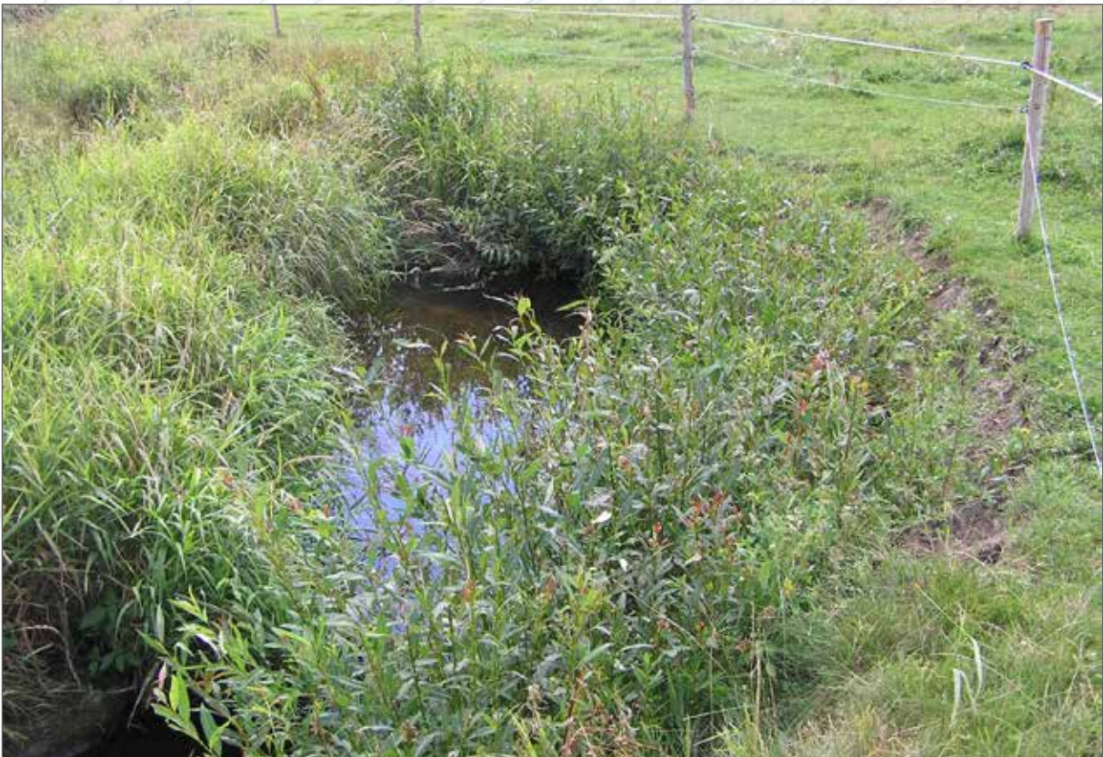
Obr. 198b. Stav stejné sestavy dvou válců sanujících 150 cm vysokou erozní stěnu po jedné vegetační sezóně v roce 2007 (obrost v blízkosti oplůtku částečně okousaly krávy, výška obrostu do 80 cm).
