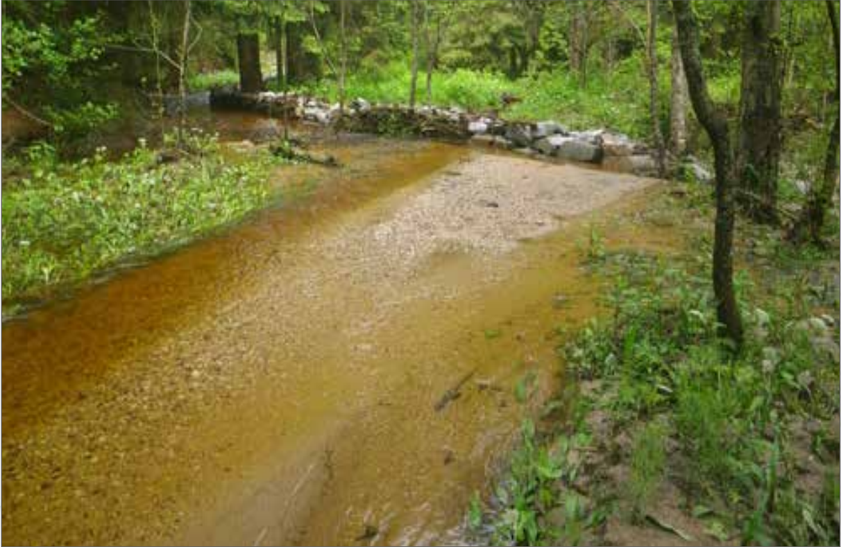
Obr. 147c. Opatření na Lučním potoce v povodí Zlatého potoka po opadu vysoké vody – hrubší písek se ukládá v trase koryta, jemnější sediment na bocích (mimo záběr).
