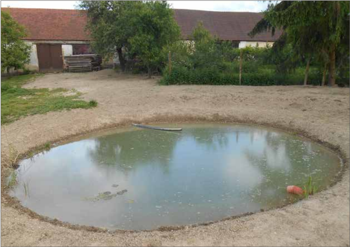
Obr. 83a. Malý dočišťovací rybník u zemědělské usedlosti v obci Malovice u Vodňan za domovní ČOV pro pět ekvivalentních obyvatel krátce po svém založení (prostá zemní nádrž v jílovitě zemině). První nádrž ze série dvou nízko zatěžovaných biologických nádrží.
