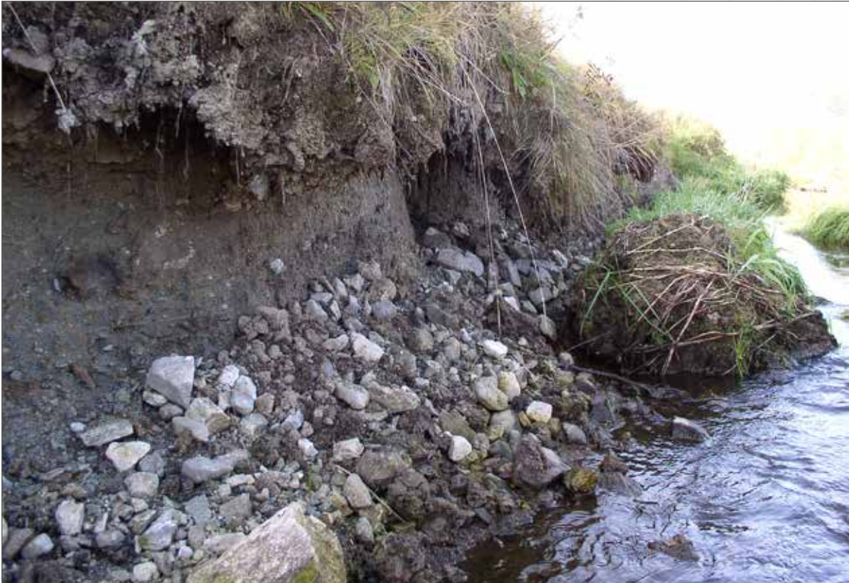
Obr. 150a. Erodující koryto Blanice.
