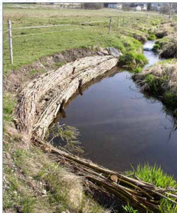
Obr. 151c. Metrová postupující eroze stabilizovaná haťošťerkovým oživeným válcem v listopadu 2006.
