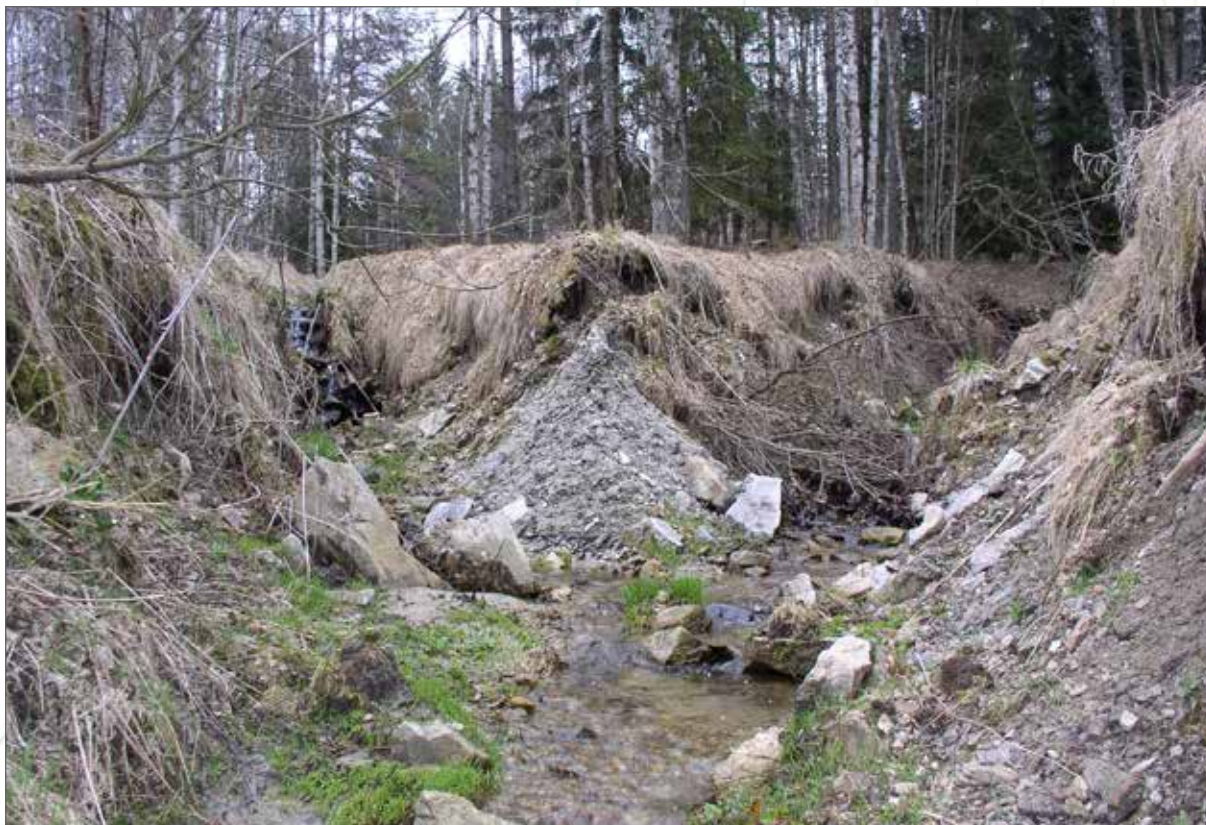
Obr. 131a. Eroze a její důsledky. V nestabilním podloží uměle zahlubené strouhy o hloubce a šířce 0,5 m rychle erodují na strže o hloubce až 2 m (Vyšenský potok 2005, výška vody za běžného průtoku). Hrubý kámen, pokud je přítomen, zůstává na místě.
