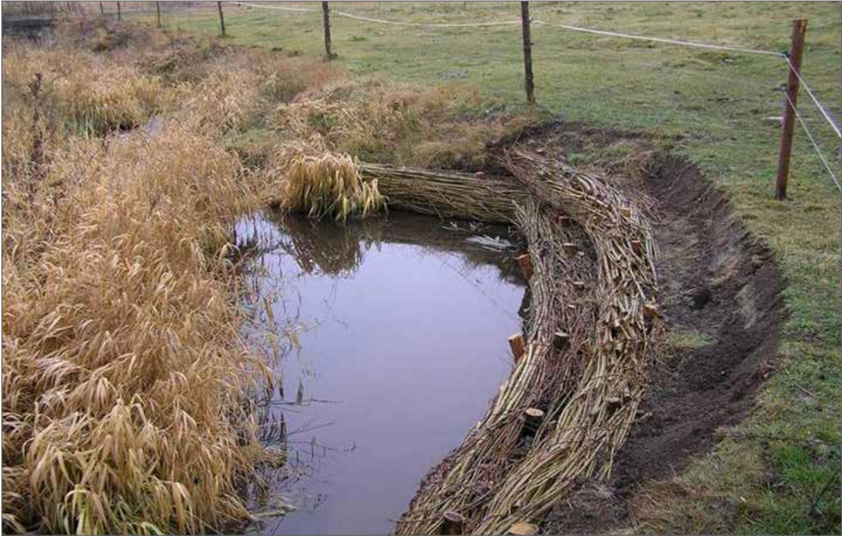
Obr. 198a. Instalaci většího množství oživených hačošterkových válců do toku podle projektu Vejmělkové a Simona (2006) realizoval v listopadu 2006 správce toku ZVHS Prachatice (dnes s. p. Povodí Vltavy).
