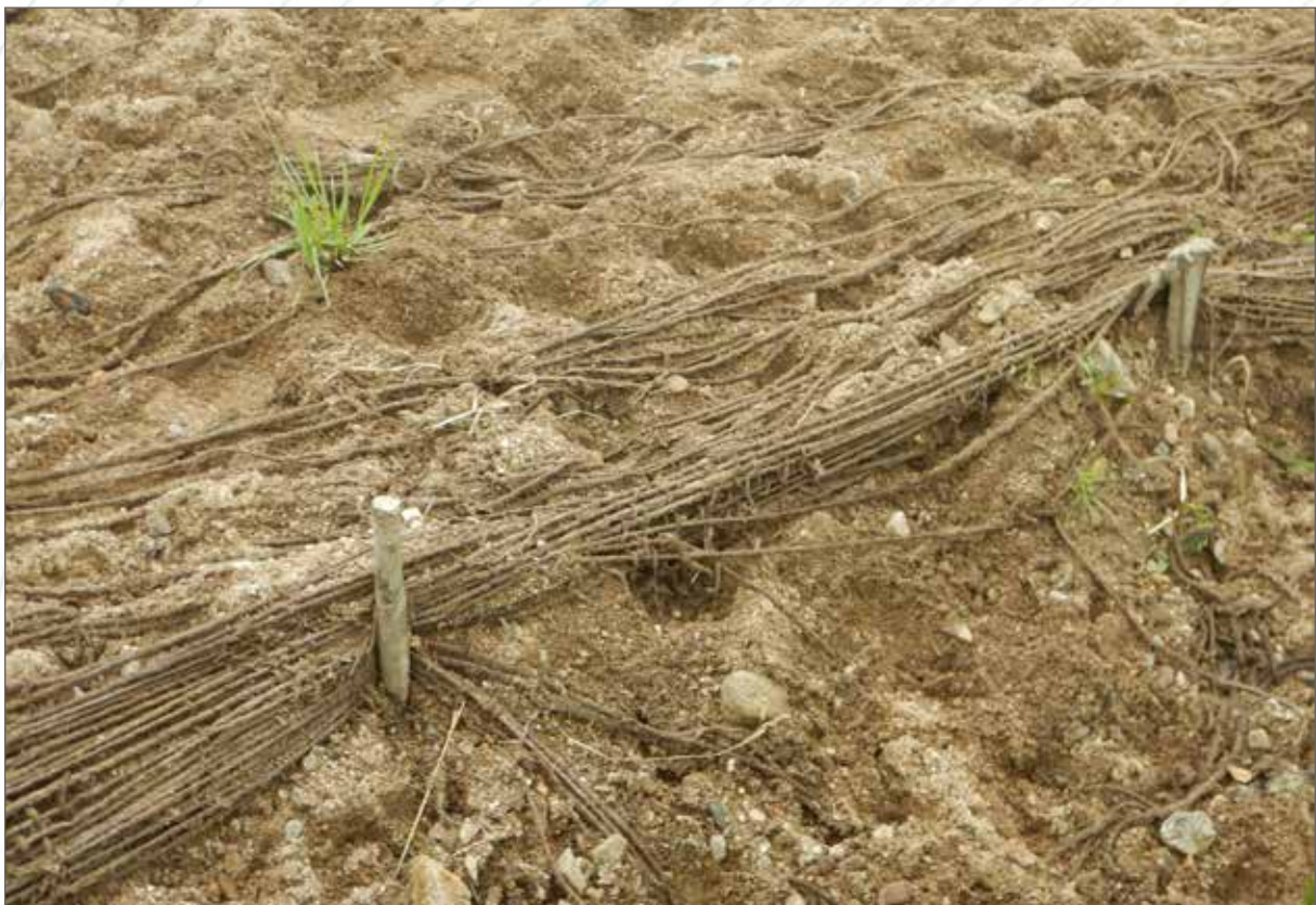
Obr. 158b. V současnosti je meandr celkově již stabilní, i když většina vrbových řízků se neuchytila.
