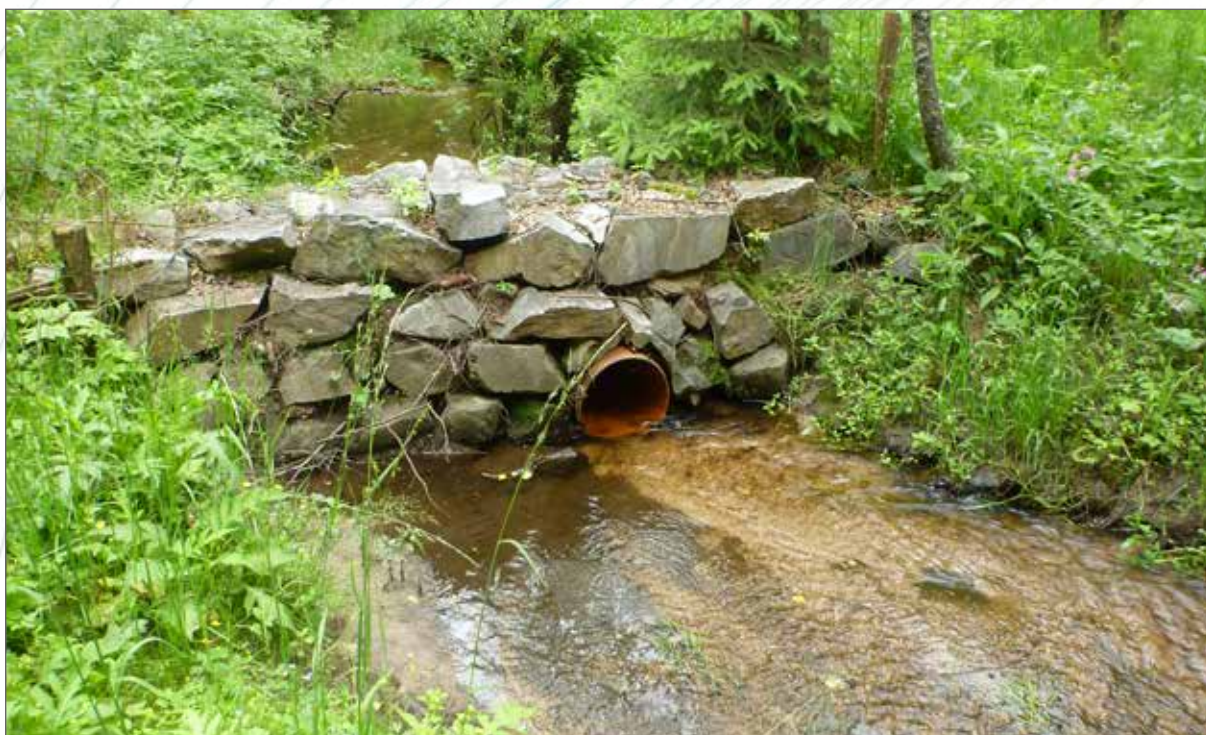
Obr. 144. Polopropustná přehrážka. Tato přehrážka je za normálního vodního stavu průtočná, v případě zvýšení průtoku ale protéká jen část určená kapacitou trubky. Nadbytečný průtok se vzedme a vybřeží určeným směrem. Trubka musí být stále zavodněna a bez proudového skoku, aby netvořila migrační překážku pro pstruhy.
