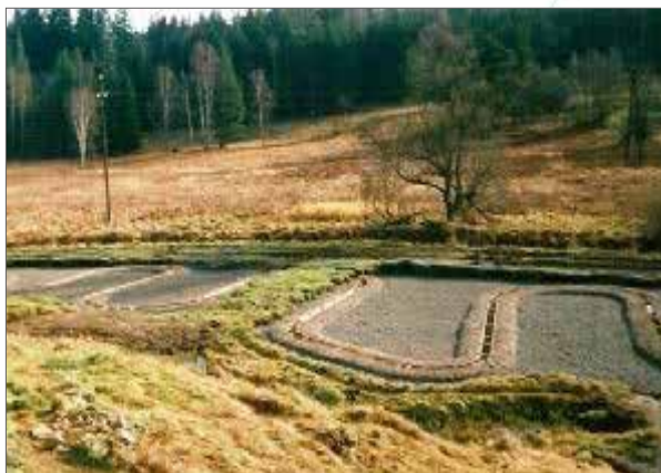
Obr. 138a. Odchovné a reprodukční prvky ve fázi stavby. SORP – NPP Blanice – viditelná je vrstva obohacené zeminy s drny podél budoucí trasy.
