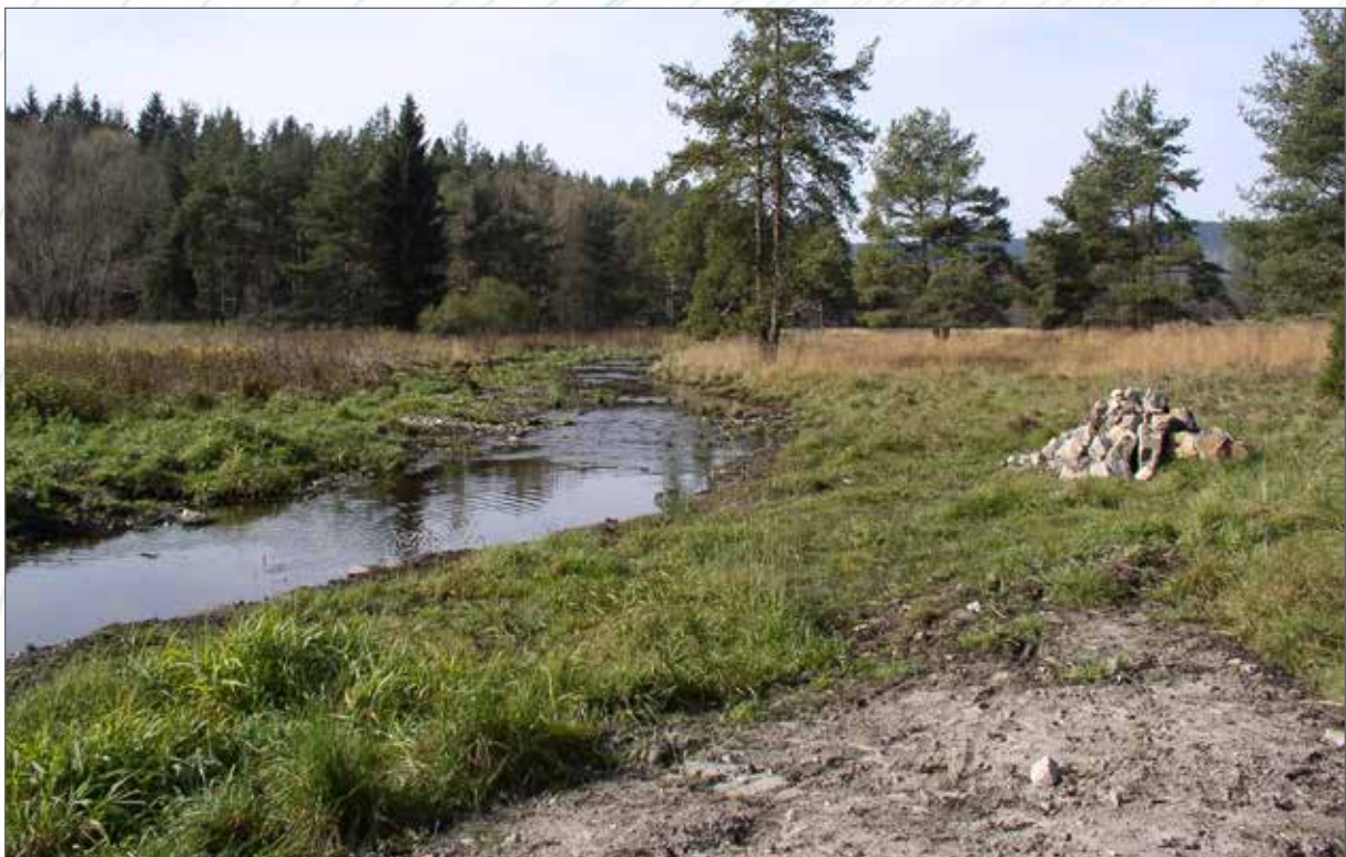
Obr. 145b. Na sedimentační tůň na Zbytinském potoce navazující volný rozliv do vysokostébelné nivy s chřasticí a tužebníkem. Tůň zachycovala písek a rozliv naopak část jemných jílových částic. Sediment z tůň musel být opakovaně odstraňován pomocí bagru.
