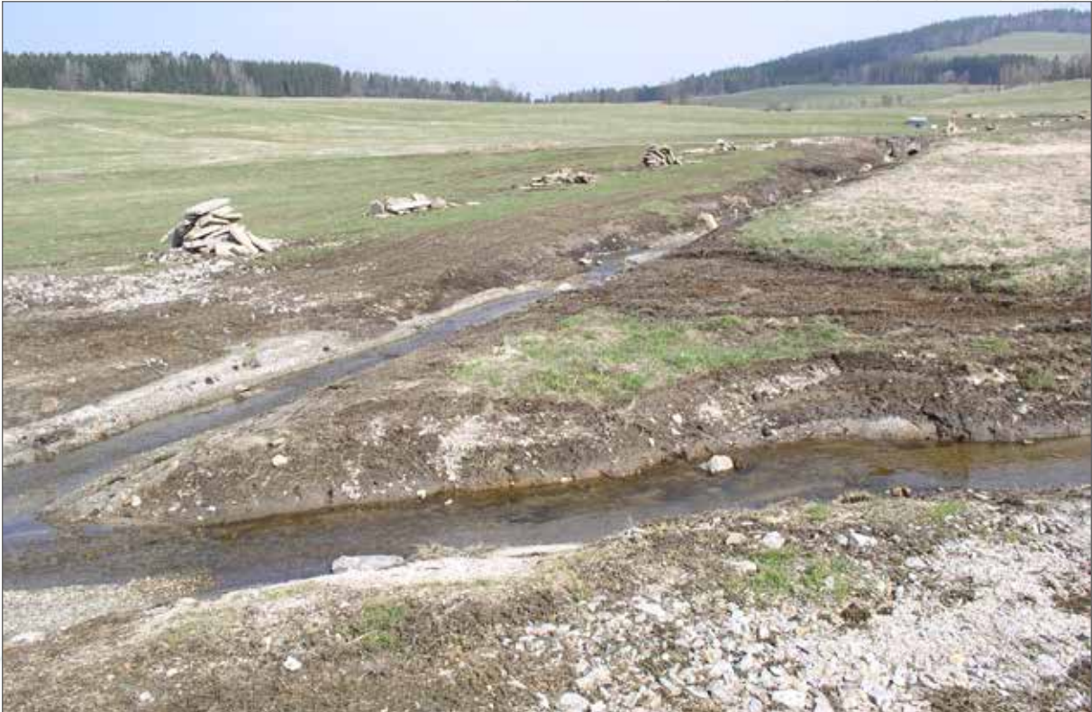
Obr. 134a. Zbytinský potok a Sviňovická strouha (ústí – vpravo) bezprostředně po revitalizaci. Vedle koryta Zbytinského potoka jsou patrné zbytky vytrhaného betonového opevnění, tok zůstal zahlouben a napřímen.
