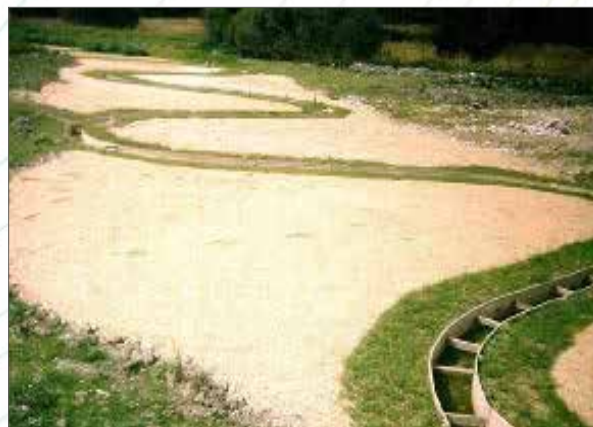
Obr. 138b. LORP – NPP Lužní potok – kolem dosud suchého koryta je vidět postupně prokořeňující drn. Zbývá plocha obou ORP pak bude překryta překompostovanou zeminou obohacenou o vápník v organické podobě (blíže k možným chybám při konstrukci viz Příloha 4).
