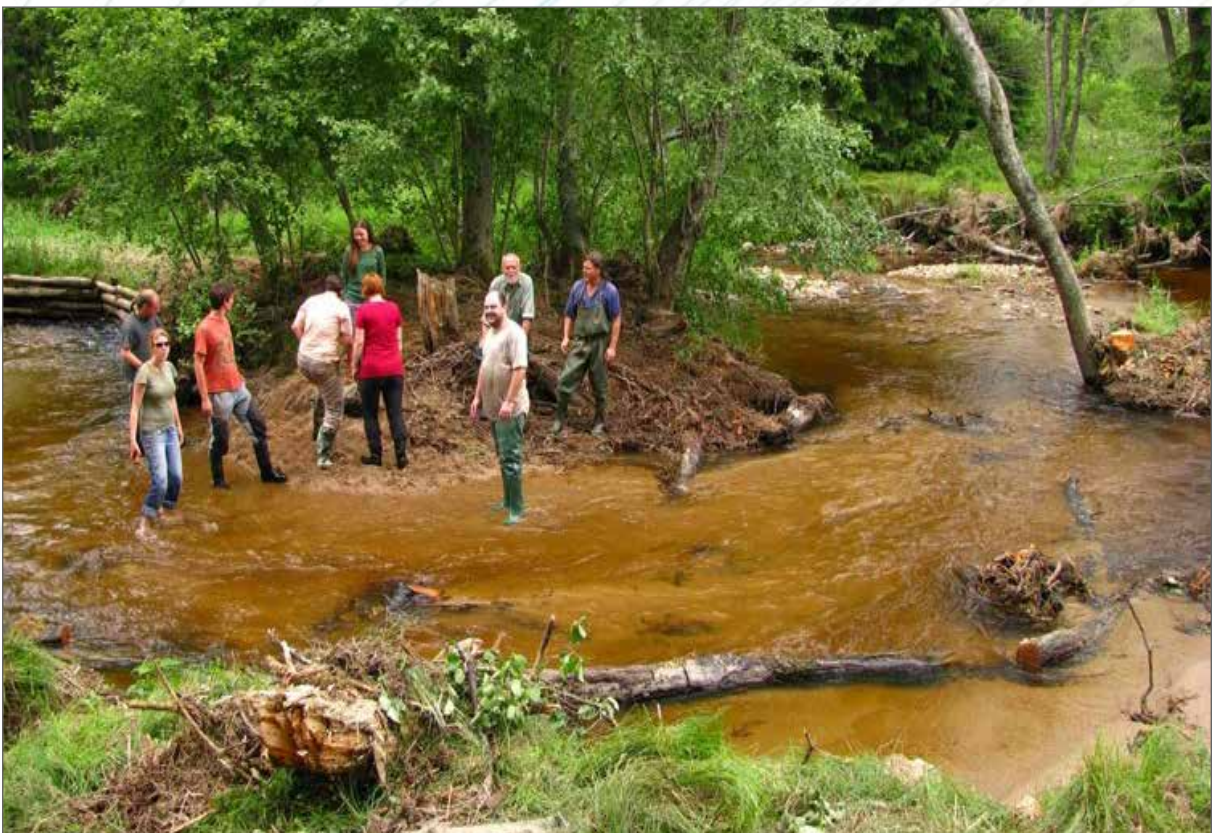
Obr. 156b. Obnažené sedimenty po odstranění zátarasu.
