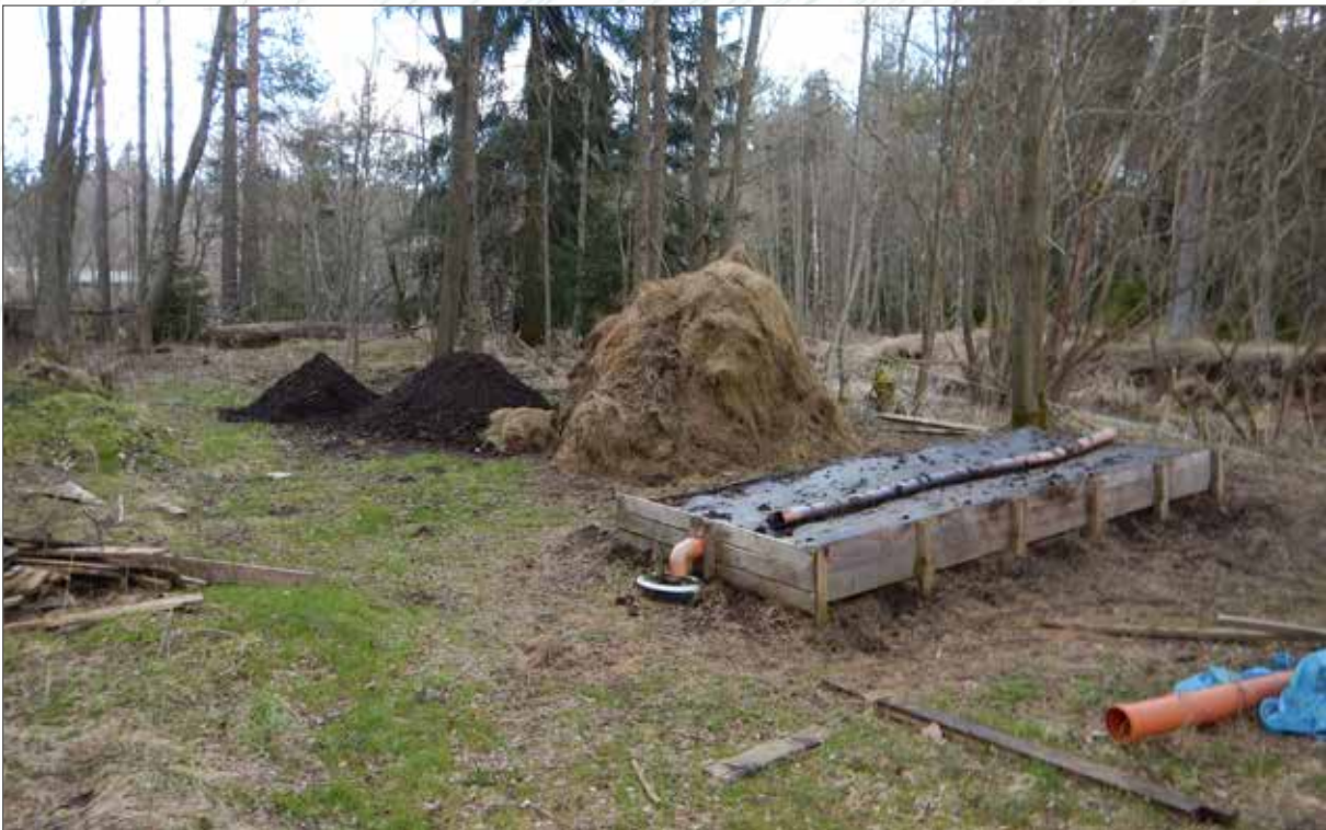
Obr. 79b. Tvorba kompostu na základce s odvodem výluhů do sběrné nádoby (vpředu), v pozadí jsou zachyceny komposty různého stáří.
