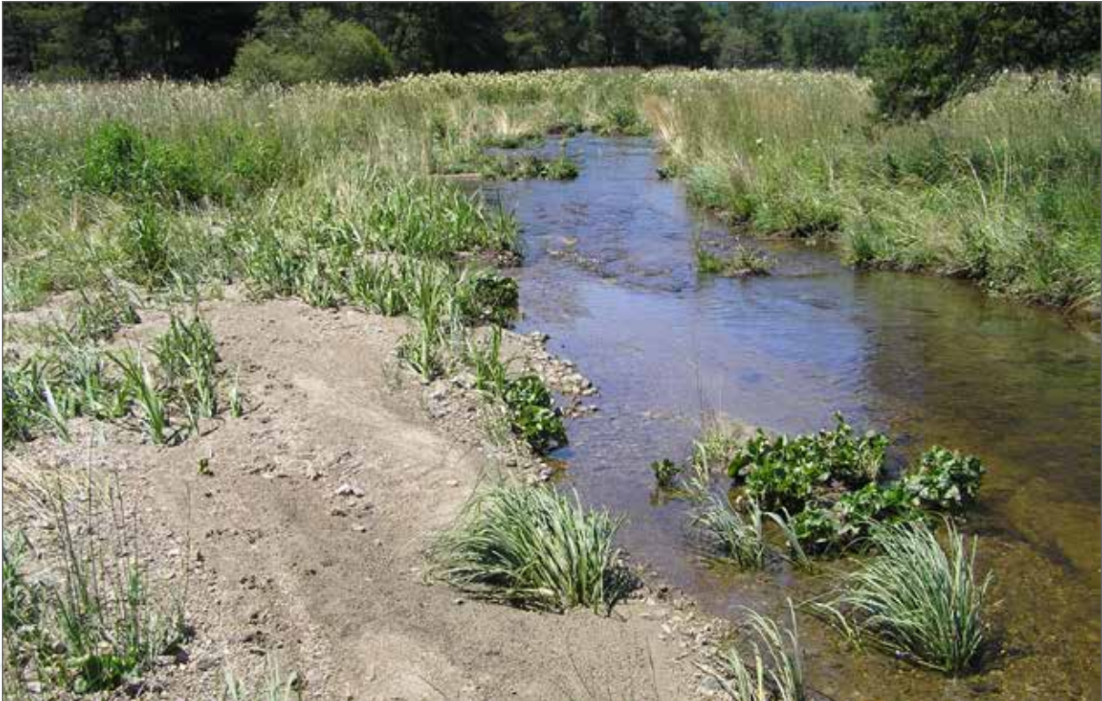
Obr. 142a. Zachytávání erozních splavenin sedimentační tůň. Sedimentační tůň pod obcí Zbytiny – v levé části obrázku je dobře patrné velké množství písku, zachycené tůň při zvýšeném průtoku, na pravé straně odtéká hlavní proud do vysokostébelné nivy, kde sedimentují jemné usazeniny (rok 2012).
