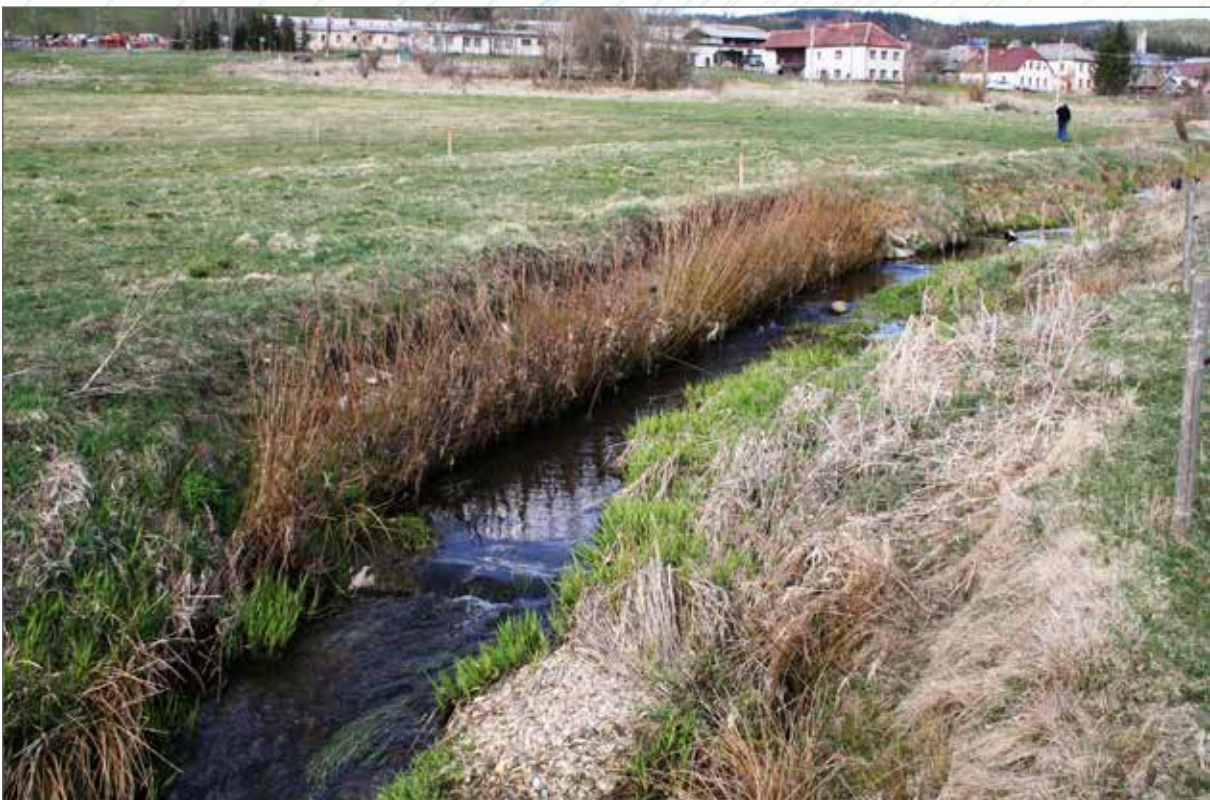
Obr. 150b. Zbytinský potok, Zbytiny – zpevnění erodujícího koryta haňošterkovým válcem. Obrostlý haňošterkový válec po první vegetační sezóně (podrobněji viz Příloha 23).
