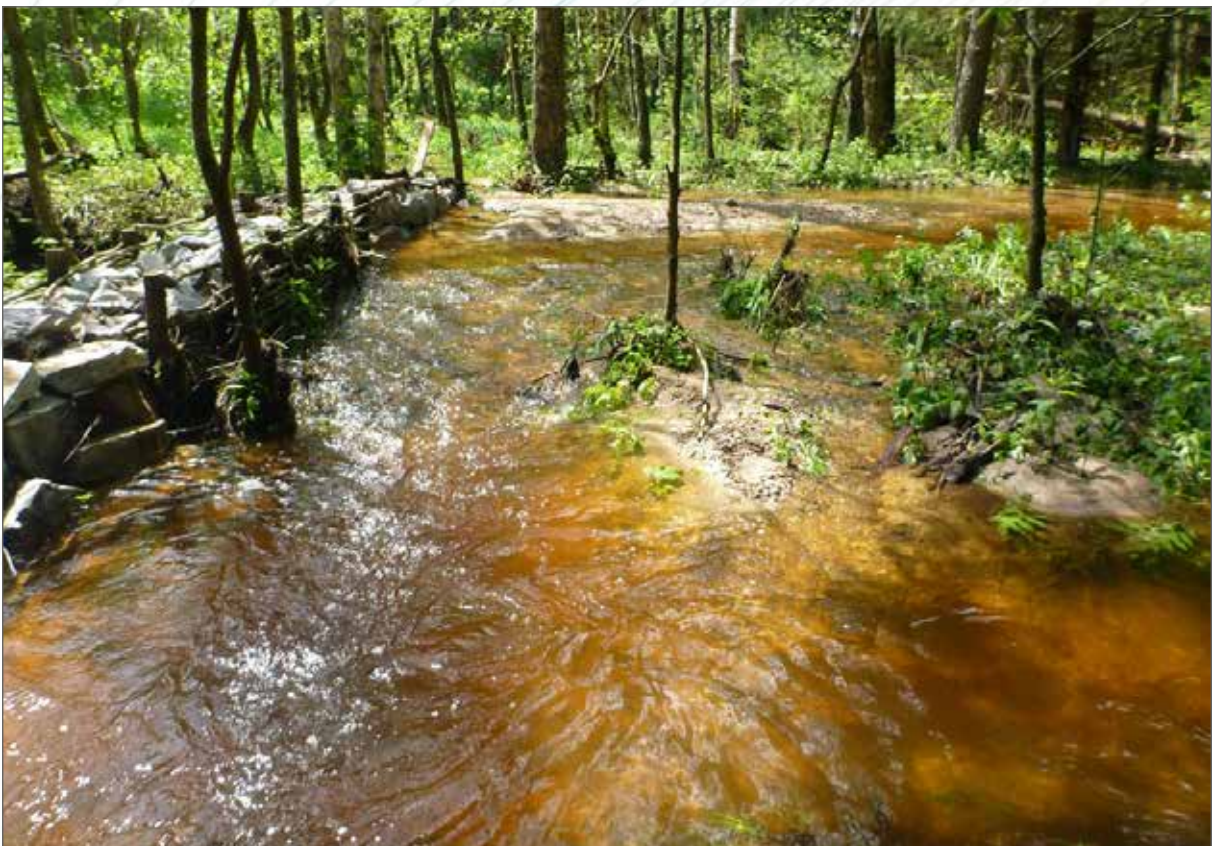
Obr. 147b. Opatření na Lučním potoce v povodí Zlatého potoka při povodni.
