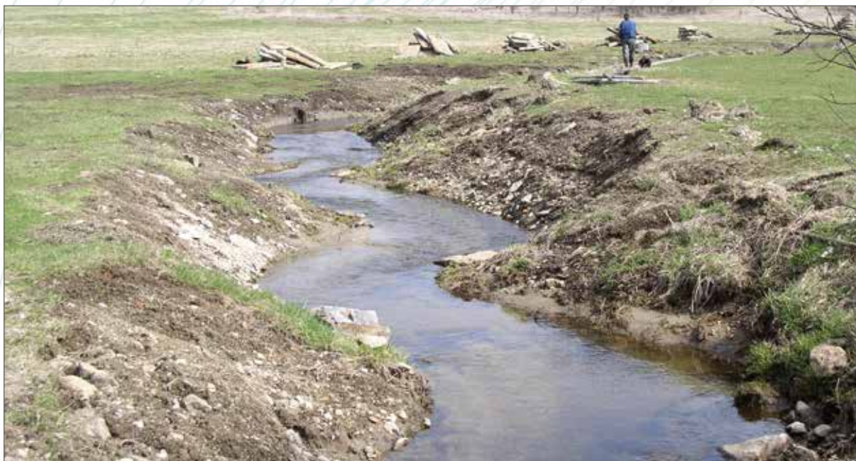
Obr. 194b. V listopadu 2004 byla provedena částečná revitalizace koryta – vytrhání betonového opevnění a naznačení meandrů.
