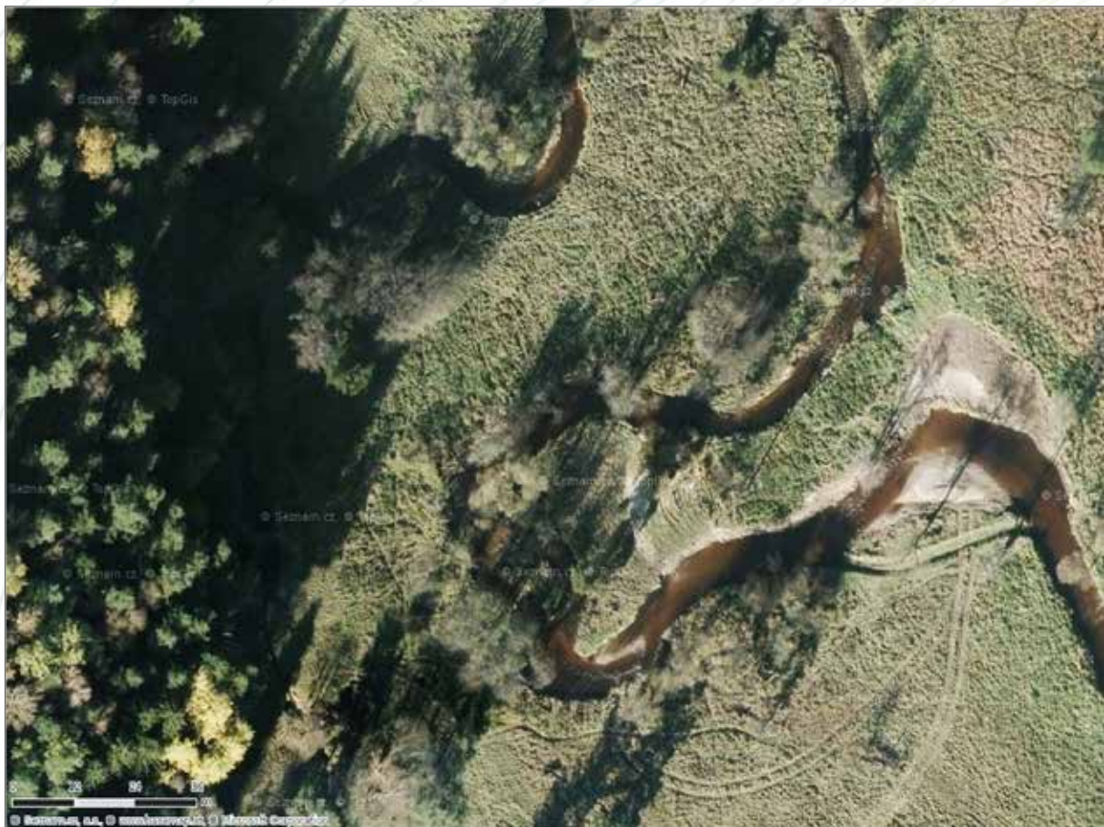
Obr. 157. Zpevnění meandru pod elektrovodem na hlavním toku Blanice – lokalita a rozsah prací. Zdroj: Mapy.cz, © Seznam.cz, a. s., © TopGis, s. r. o.
