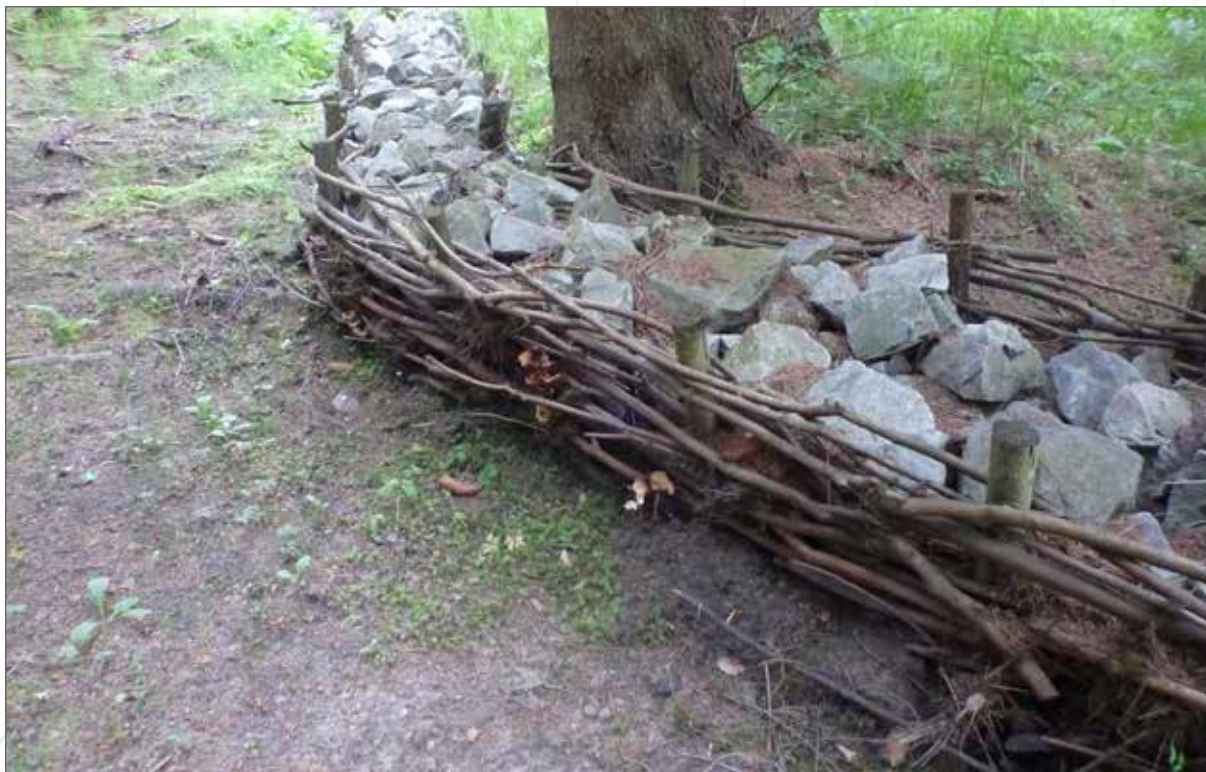
Obr. 143. Hrázka tvořená dvojitým vrbovým oplůtkem a vyplněná uvnitř lomovým kamenem. Při vyšších vodních stavech voda částečně hrázku obtéká, částečně protéká skrz. Jemnozrnné i hrubozrnné plaveniny se zachytávají před hrázkou.
