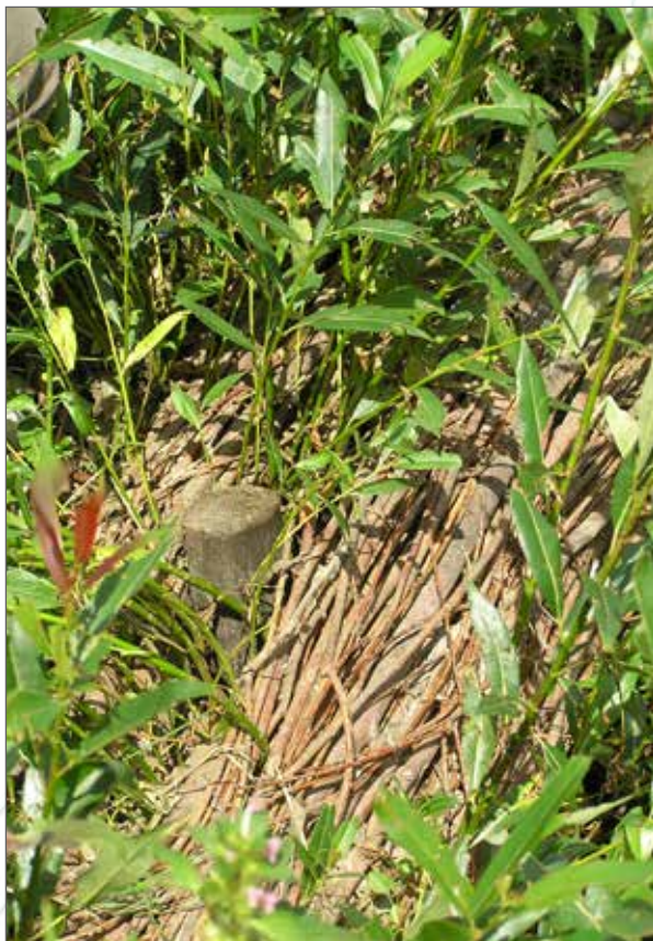
Obr. 199a. Detail oživeného haťošterkového válce po jedné vegetační sezóně v roce 2007 (upevňovací kůl ze smrkové kulatiny, svazky proutí svázané páleným drátem silně obrážejí a zespoda prokořeňují).
